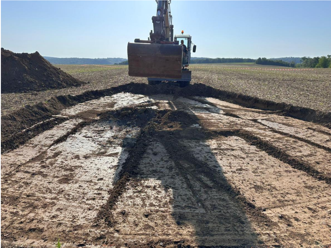
Mutterboden wird abgetragen
