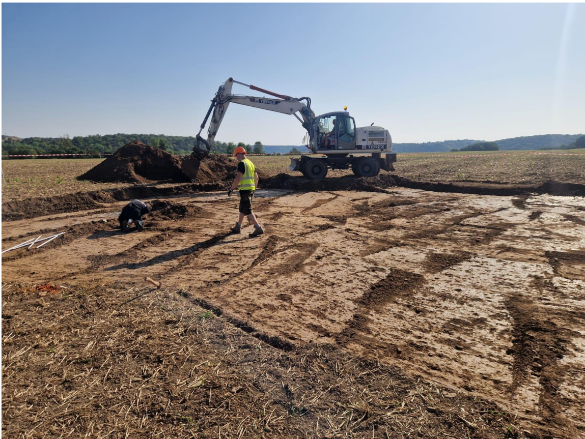
Mutterboden wird abgetragen
